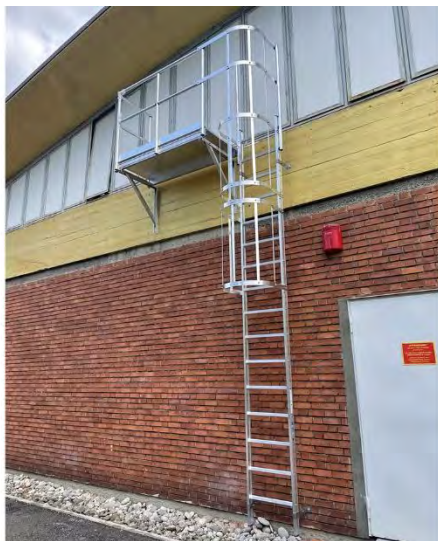
– esempio di linea vita e di scala a gabbia da installare
