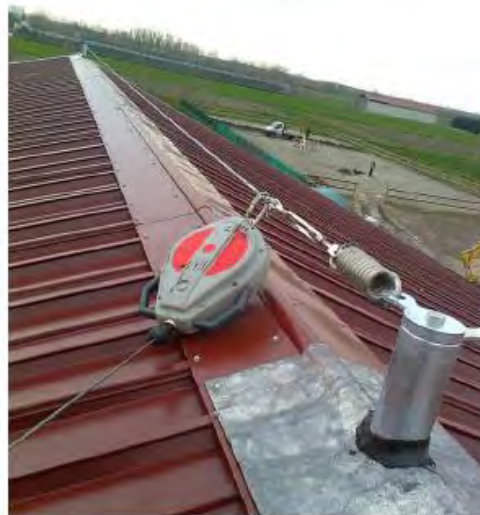
– esempio di linea vita e di scala a gabbia da installare
