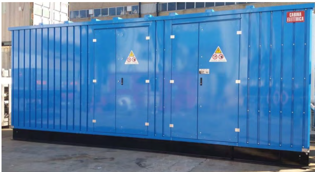
– tipologia di cabina tipo shelter per la connessione alla rete MT
